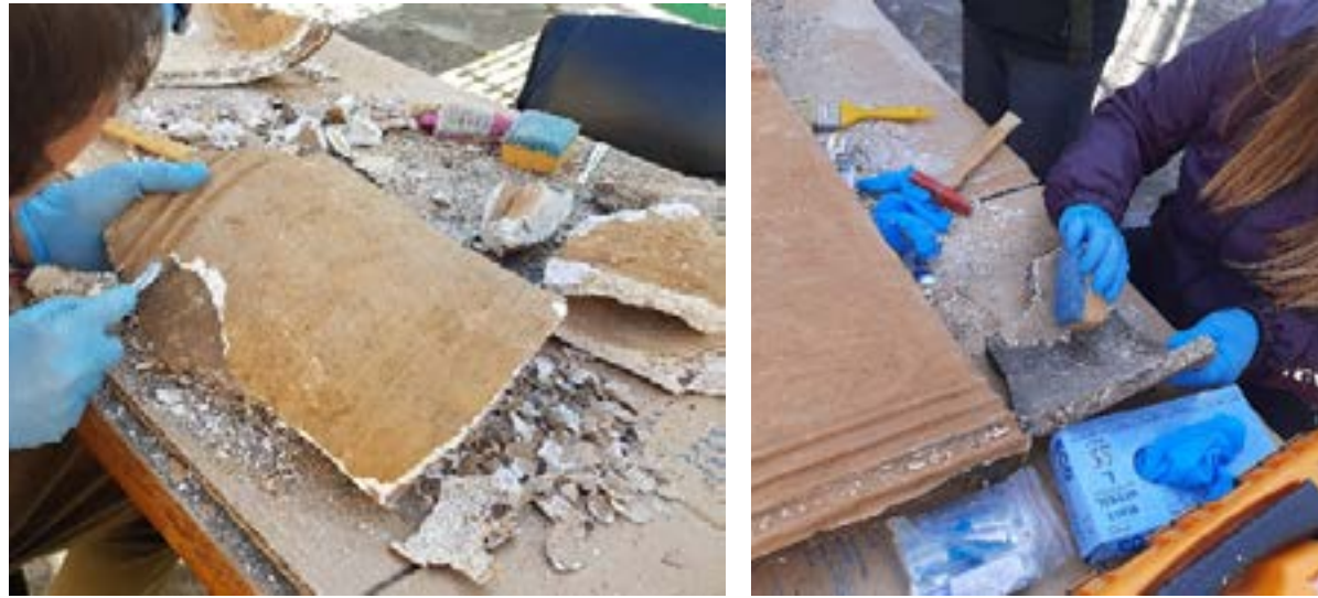
Görsel 12-13: Yüzeyleri ve İç Kısımları Alçı ile Sıvanan Parçaların Temizliği, 2021
