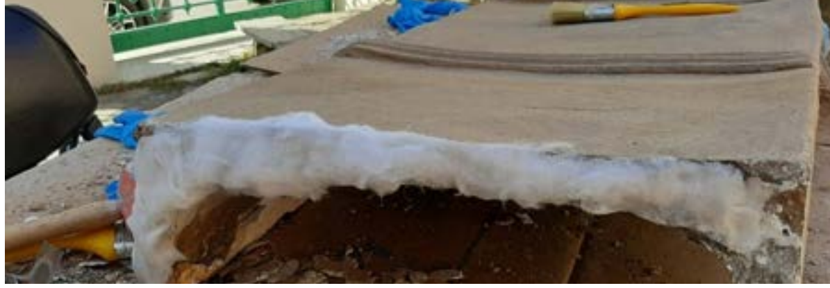
Görsel 11: Eski Yapıştırıcıların Aseton ile Yumuşatılarak Temizlenmesi, 2021
